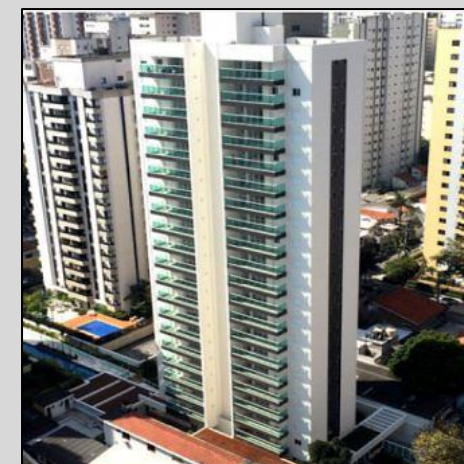
YANG BROOKLYN ARCHTECH ENGENHARIA R. PE ANTONIO JOSÉ DOS SANTOS,258 A= 9.200M 2 / CONCRETO ARMADO
