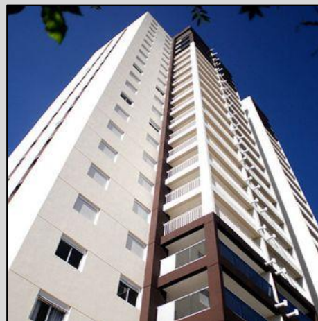
BLESS ARCHTECH ENGENHARIA AV. FAGUNDES FILHO, 8251 – SAÚDE A= 11.300M 2 / CONCRETO ARMADO
