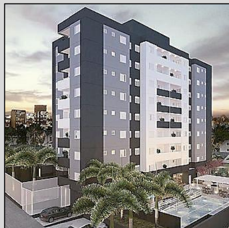
EDIFÍCIO ELEMENTARE LIDERARE CONSTRUTORA R. PADRE LEÃO PERUCHE, 156 - VL MAZZEI A=4.500 M 2 /ALVENARIA ESTRUTURAL
