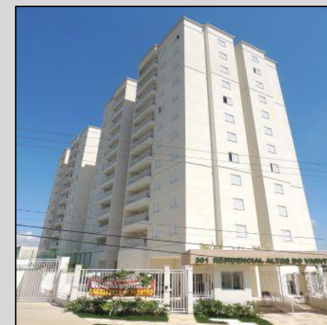
ALTOS DO VARVITO WALCON CONSTRUTORA R. AUGUSTO FRANCISCHINELLI – ITÚ A= 13.000M 2 / ALVENARIA ESTRUTURAL
