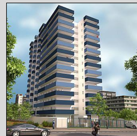
TORRE CALABRIA MARTINS MA CONSTRUTORA LTDA R. FERNÃO DE MAGALHÃES – MÓOCA A=7350 M 2 / ALVENARIA ESTRUTURAL
