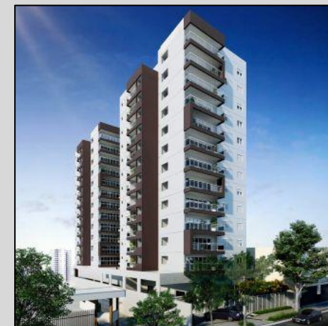
SYNC PÇ DA ÁRVORE ARCHTECH ENGENHARIA RUA BERTIOGA, 291 – PÇ DA ÁRVORE A=9.600M 2 / ALVENARIA ESTRUTURAL
