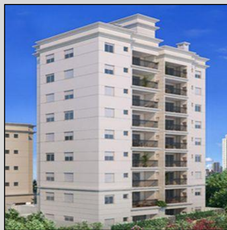
LAGOA VERDE ENGEPLAN INCORPORADORA R. LAGOA VERDE, 261 - PARADA INGLESA A= 6.300 M 2 /CONC. ARMADO / SAPATAS
