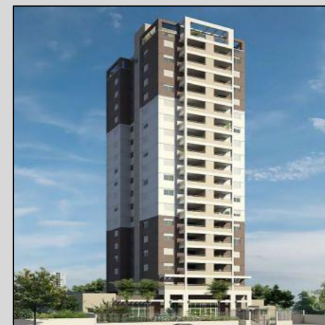
TIME QUALITY MIRMAN AV. PARADA PINTO, 1692 - SÃO PAULO A= 6.000M 2 / CONCRETO ARMADO
