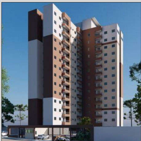
PANAMBY UNIÃO VG R. FRANCISCO AIRES, 434- GUARULHOS A=8.200 M 2 / ALV. ESTRUTURAL / PROTENSÃO
