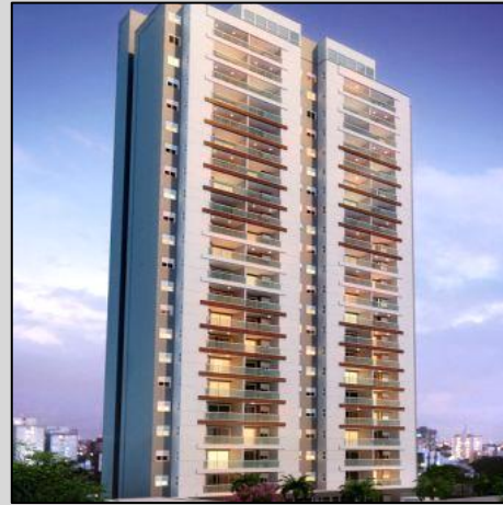
SMART HOME SANTANA AYACHE INCORPORADORA E EVO RUA ALFREDO PUJOL SANTANA A=11.500 M 2 / CONCRETO ARMADO
