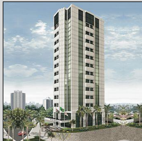
VILA MARIA TOWER OSPE CONSTRUTORA AV. CEREJEIRAS X RUA CECILIA MEIRELES A= 5.200 M 2 / CONCRETO PROTENDIDO
