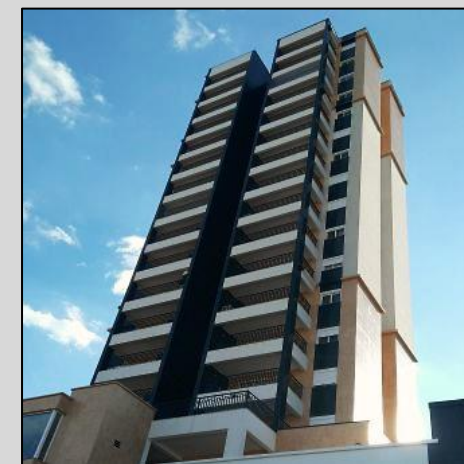
EDIFÍCIO CITRON BRAXFO EMPREENDIMENTOS R. CAROLINA SOARES, 109 – LIMÃO A=6.300 M 2 / CONCRETO ARMADO
