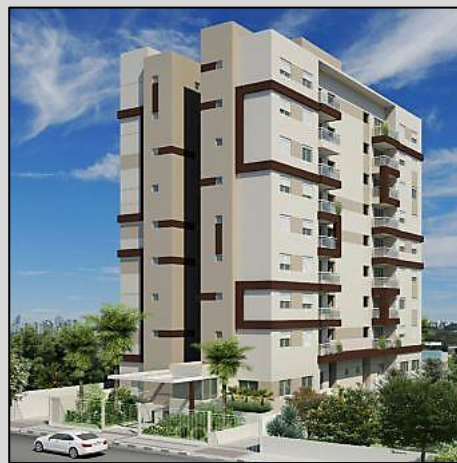
EDIFÍCIO RESIDENCIAL VIVEIROS CLL CONSTRUTORA RUA VIVEIROS DE CASTRO, 329 A= 4.800 M 2 /ALVENARIA ESTRUTURAL
