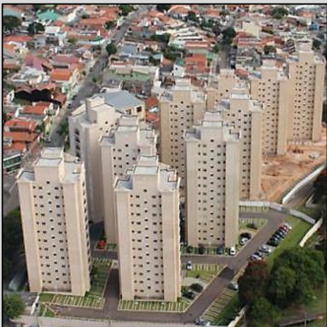
MAJESTIC JUNDIAÍ AM2 ENGENHARIA AV. AMÉLIA LATORRE - JUNDIAÍ/SP A= 30.000M 2 / CONCRETO ARMADO
