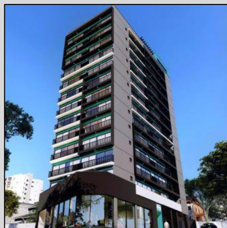
IN JD SÃO PAULO EVO CONSTRUTORA AV. LEÔNCIO DE MAGALHÃES, 889 – JD SP A=5.000 M 2 / CONCRETO ARMADO
