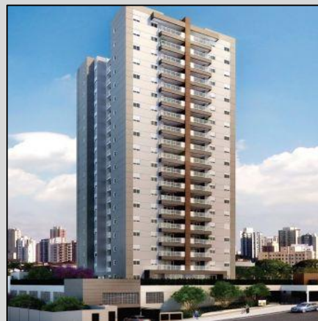
BAY VISTA SÃO FRANCISCO BAZE INCORPORADORA R. MANOEL DE ALMEIDA – VL GUILHERME A=10.400 M 2 / CONCRETO ARMADO
