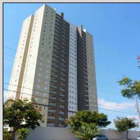
GRAND PAYSAGE CONSTRUTORA STA IZAURA AV. PLINIO MARCOS, VILA BRANCA – JACAREÍ A= 13.000M 2 / CONCRETO ARMADO
