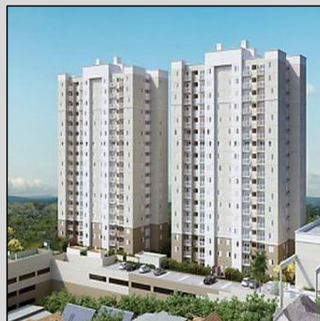
I9 HORTO I9 INCORPORAÇÃO AV. PARADA PINTO, 2511 – SÃO PAULO A= 26.000 M 2 / ALVENARIA ESTRUTURAL
