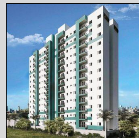
REDIDENCIAL MALIBU UNIÃO VG AV. OTÁVIO BRAGA DE MESQUITA, 3853 A=7.200M 2 / ALVENARIA ESTRUTURAL
