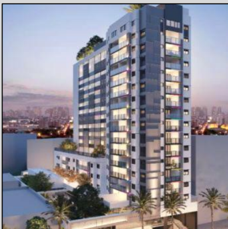
ALTIUS RESIDENCE BRAXFO EMPREENDIMENTOS RUA ALTINOPÓLIS - ÁGUA FRIA A=11.900 M 2 / CONCRETO ARMADO
